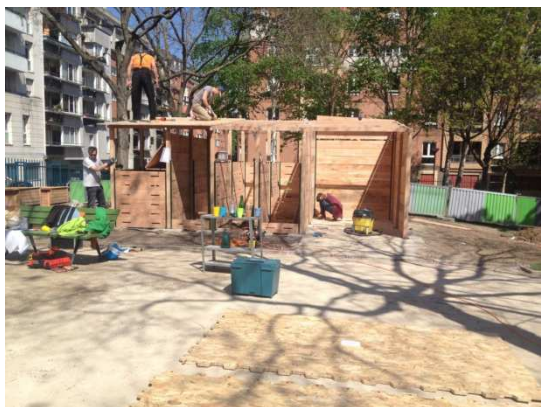
Montage du pavillon en avril 2015
